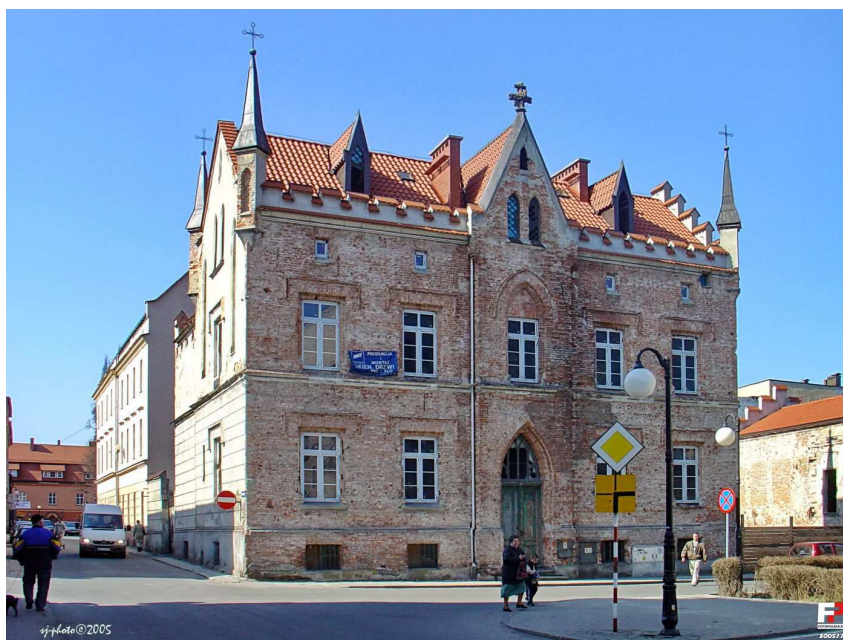
Budynek w trakcie przebudowy łącznika
